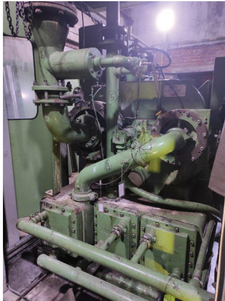
▲ Компрессор воздуха КИПиА Cameroop позиции P-701 относится к основному оборудованию цеха карбамида
