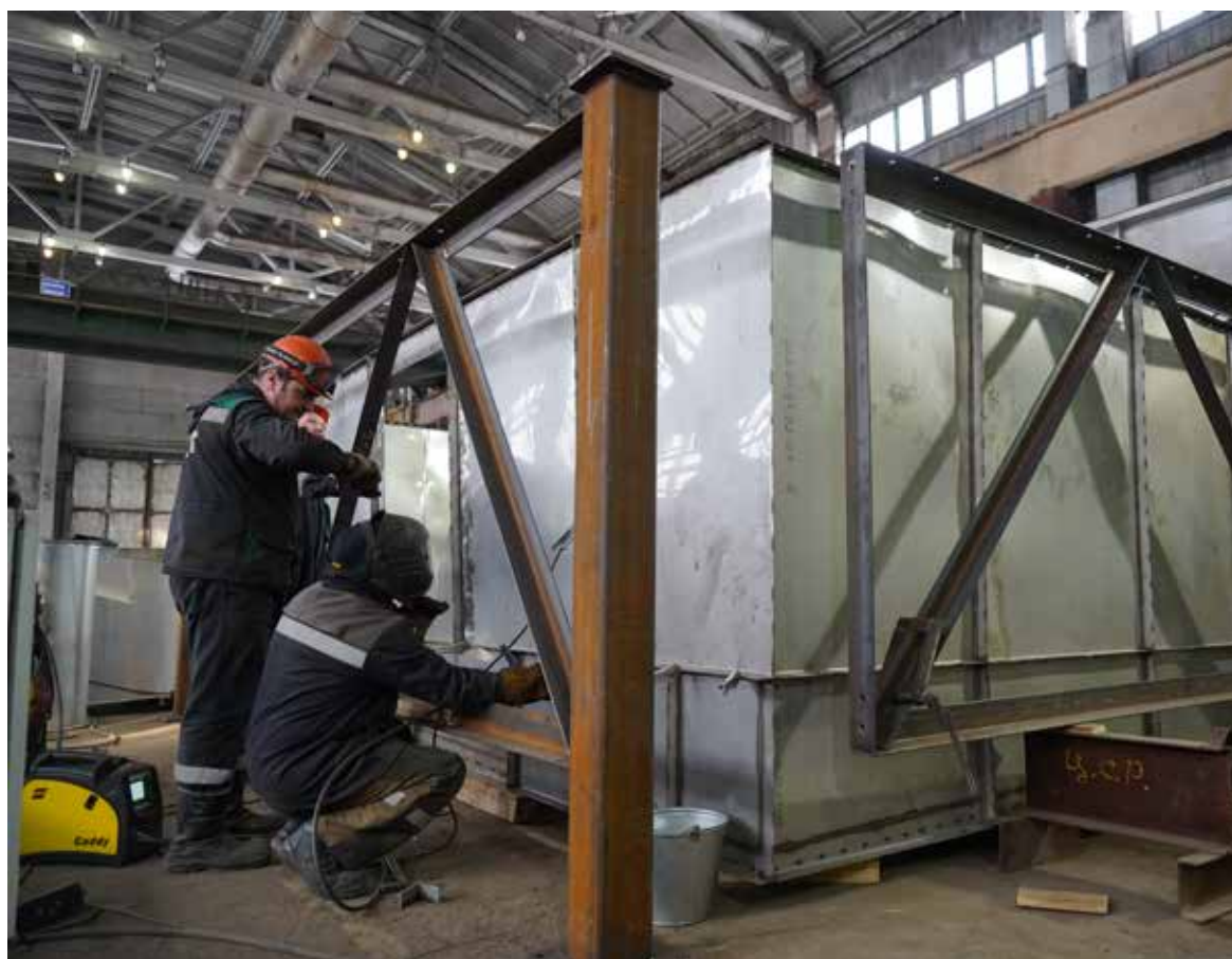
▲ В цехе специализированных работ началась урупнённая сборка двух первых модулей пылеочистки
