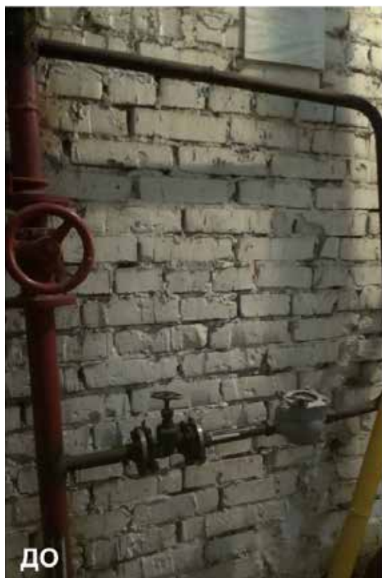
▲ Узел учёта пожарохозяйственной воды в электроцехе. До и после замены
