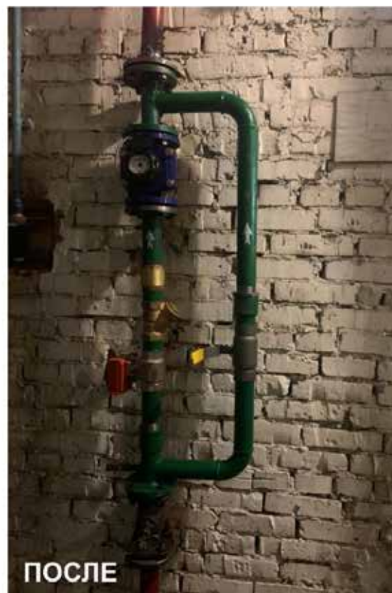
▲ Узел учёта пожарохозяйственной воды в электроцехе. До и после замены
