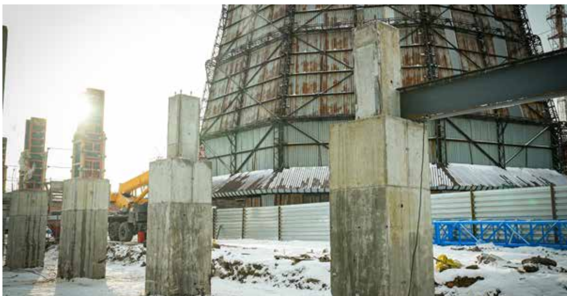
▲ На переднем плане – основа нового ВОЦ, на заднем плане – старая градирня капельно-плёночной конструкции
