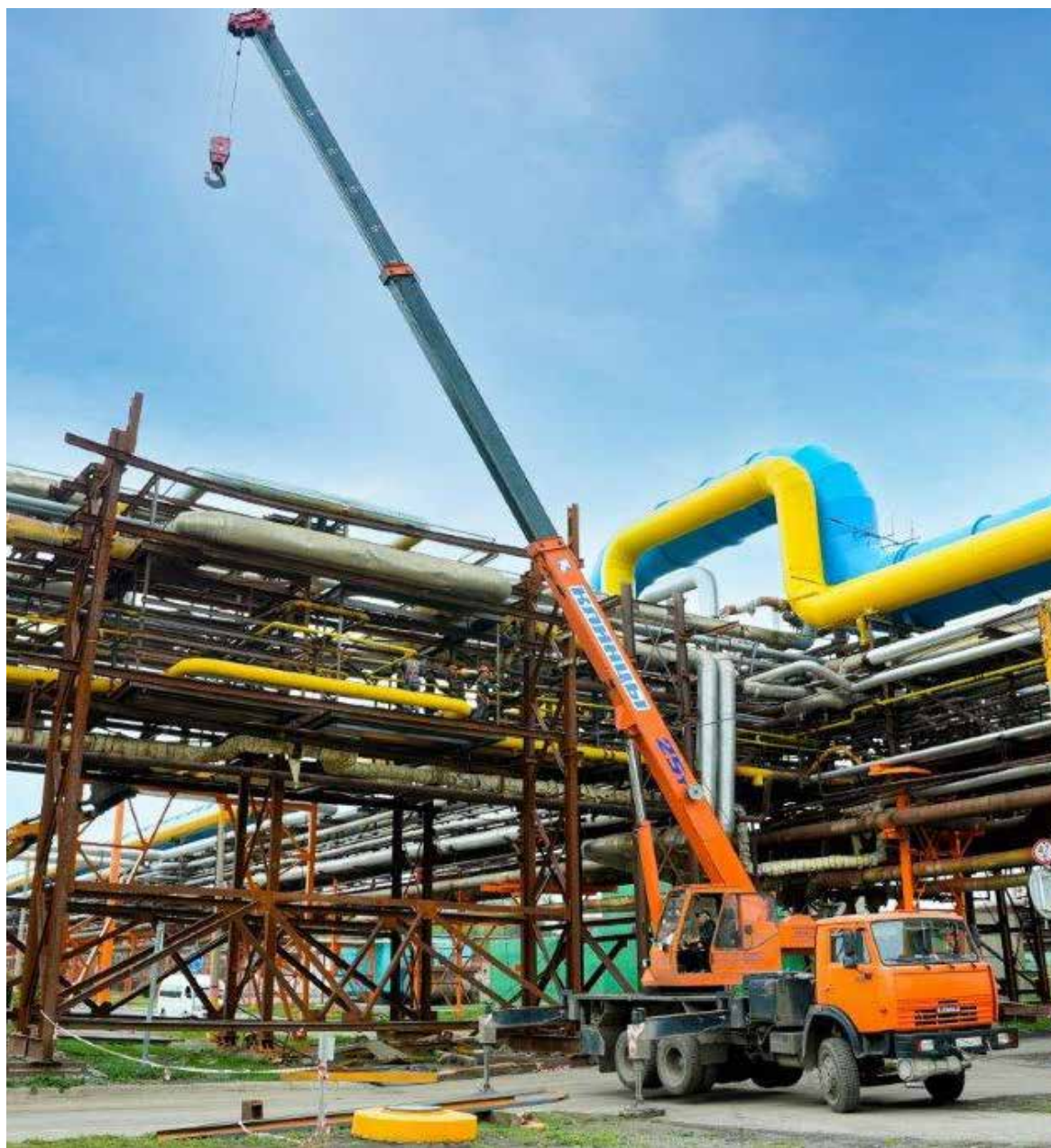
▲ Кроме замены опорной конструкции, на участках обновляются смотровые и ходовые площадки, лестницы
