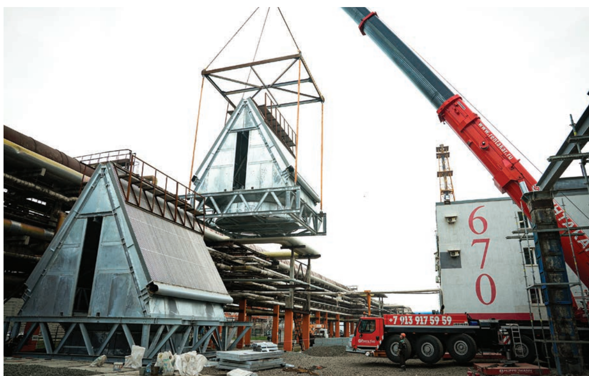
▲ Успешный ввод в эксплуатацию вакуум-вытяжки позволит добиться цеху аммиака-1 значительной экономии по газу
