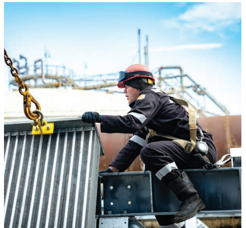
▲ Специалисты ЦМОМ ведут укрупнительную сборку модулей новой вакуум-вытяжки
