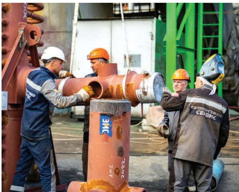
▲ Сотрудники «Белэнергомашсервис» на монтаже котельного оборудования
