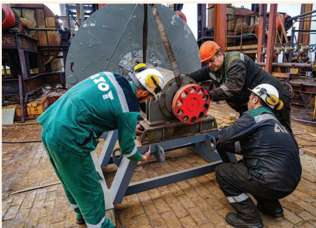
▲ Работники УГМ-3 производят демонтаж вентилятора поз. В-28/Р1
