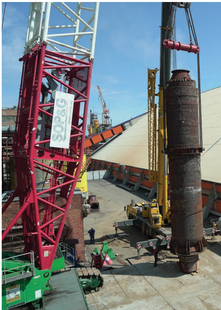
▲ Одна из важных работ этого года – замена конденсатора в цехе аммиака-2
